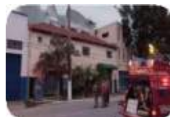
Fachada após ser contido o fogo
