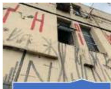
Janela lateral (dutra) aberta para descida de bens.
